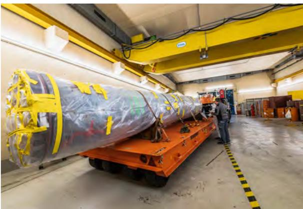
Herausforderung in der KNK: Der sieben Meter lange Waschbehälter der Natriumwaschanlage wurde am Stück in die Entsorgungsbetriebe transportiert und anschließend fachgerecht zerlegt
